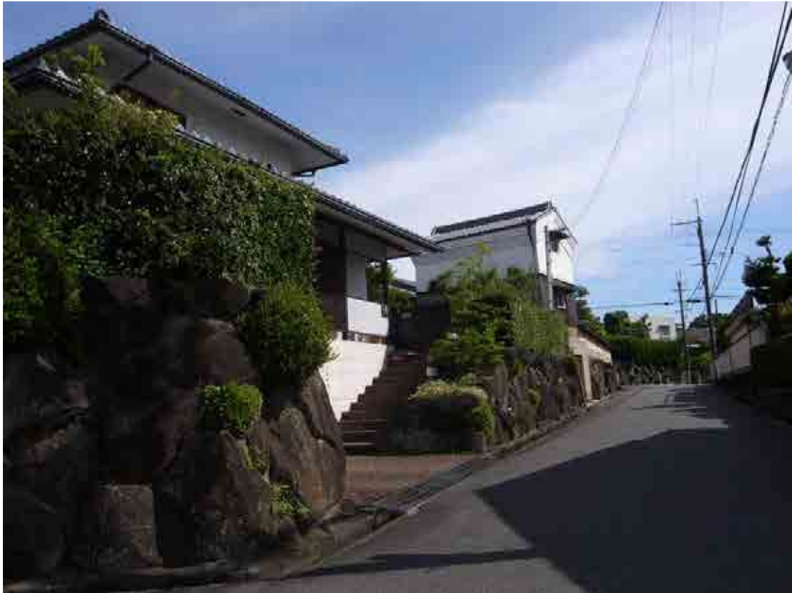
生駒石による石積み（東生駒）
