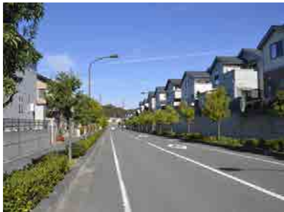
住宅地内の道路の見通し（西白庭台）
