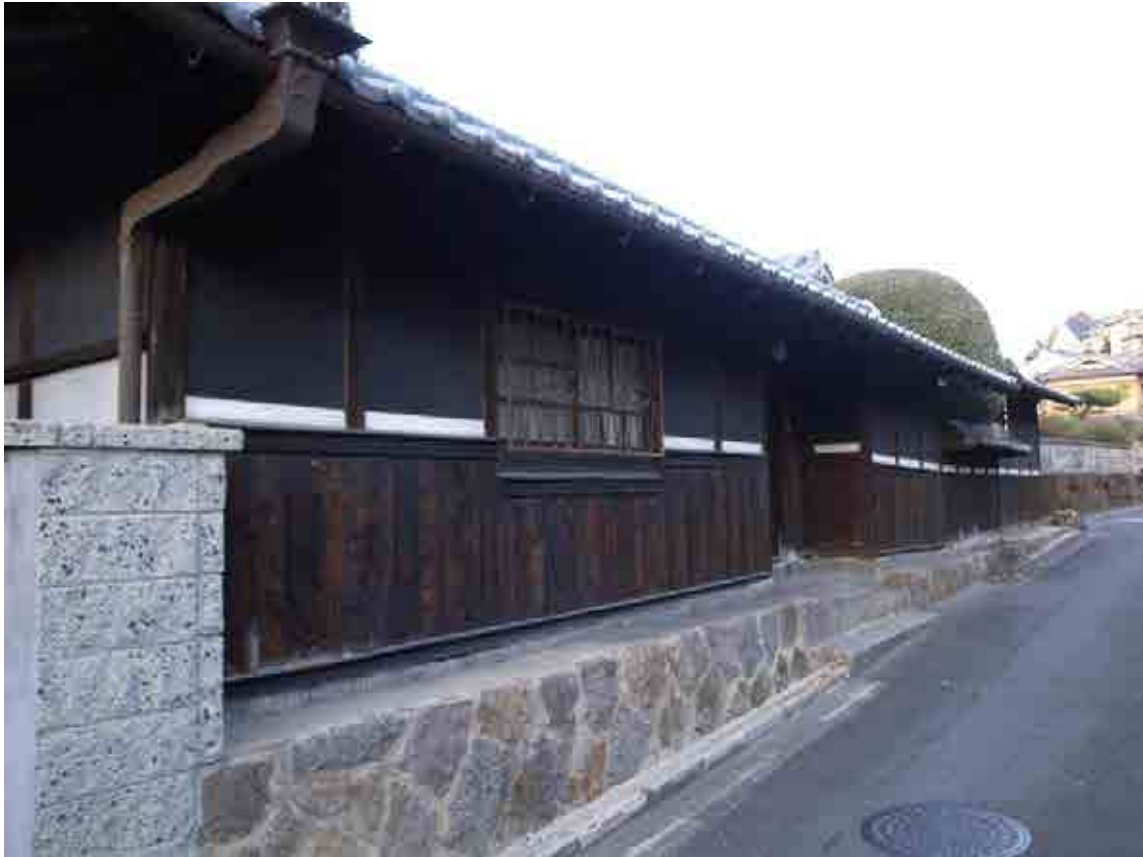
小さな石積みなどを使いながら斜面に沿って建てられた住宅（萩の台）
