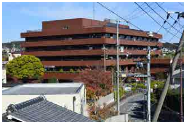
市役所は地形に沿って立地しており、出入り口も1階、2階にある（東新町）
