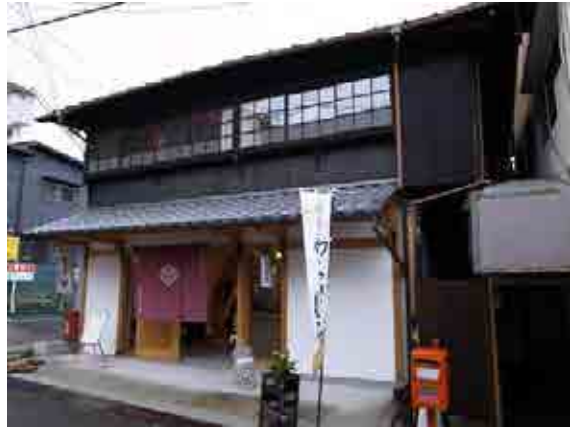
もともとの建物のデザインを継承し改修したお店（元町）
