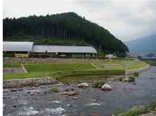
法面を分節化し、緑化を施した例
