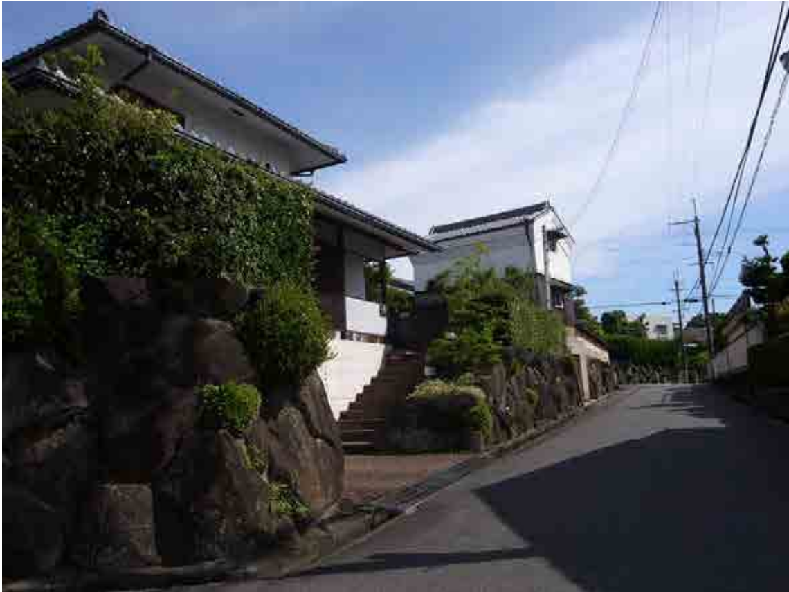
生駒石による石積み（東生駒）
