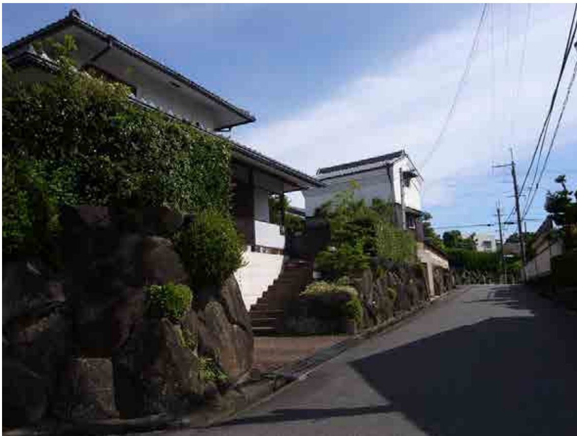
生駒石による石積み（東生駒）
