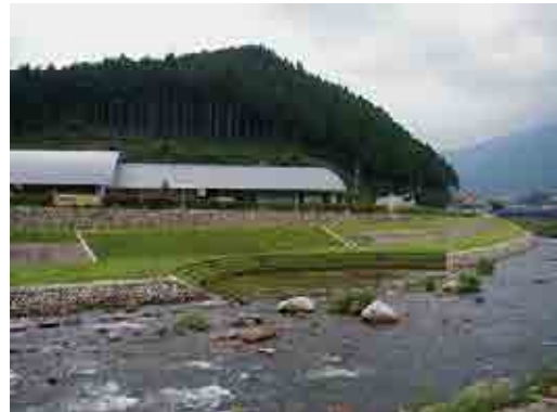
法面を分節化し、緑化を施した例
