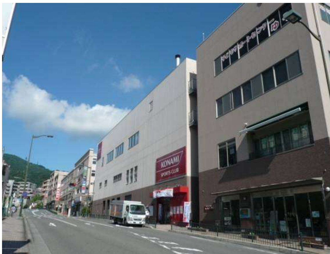
生駒駅北口：第4地区商業エリアのすっきりとした景観
