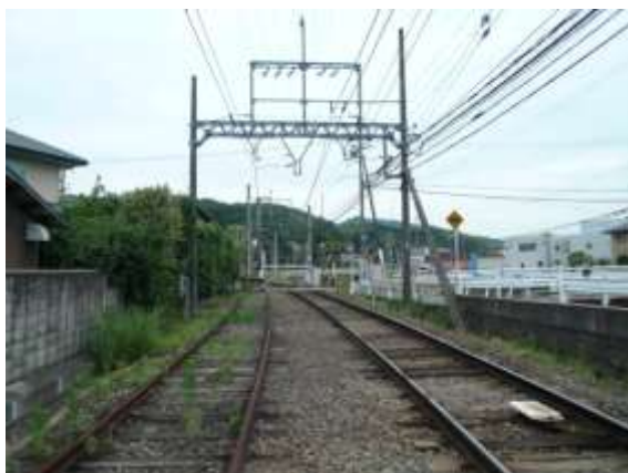
鉄道の先頭車両からの見通し
