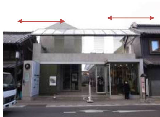
全く異なる意匠や材質ですが、通りに沿って共通する屋根の勾配や高さを継承している（川越市）
