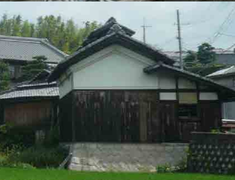
左上：入母屋造りの屋根 三角形の部分が破風
