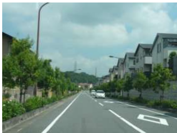
住宅地内の道路の見通し
