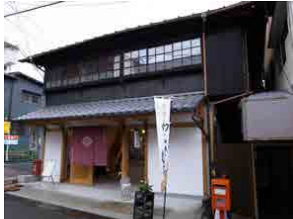
もともとの建物のデザインを継承し改修した店
