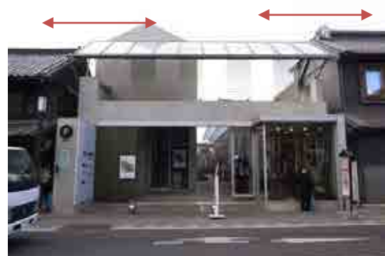
全く異なる意匠や材質ですが、通りに沿って共通する屋根の勾配や高さを継承している（川越市）
