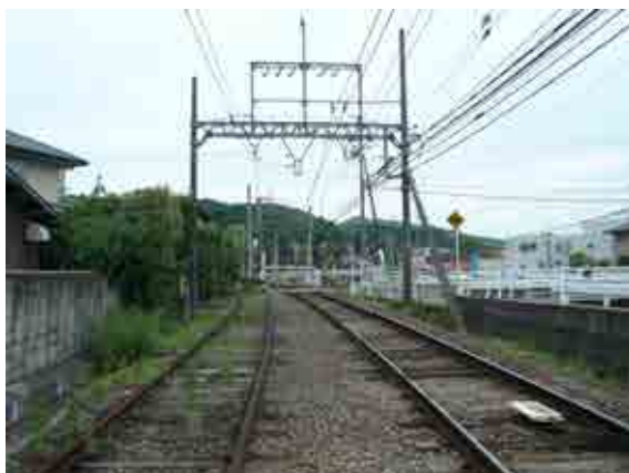
鉄道の先頭車両からの見通し
