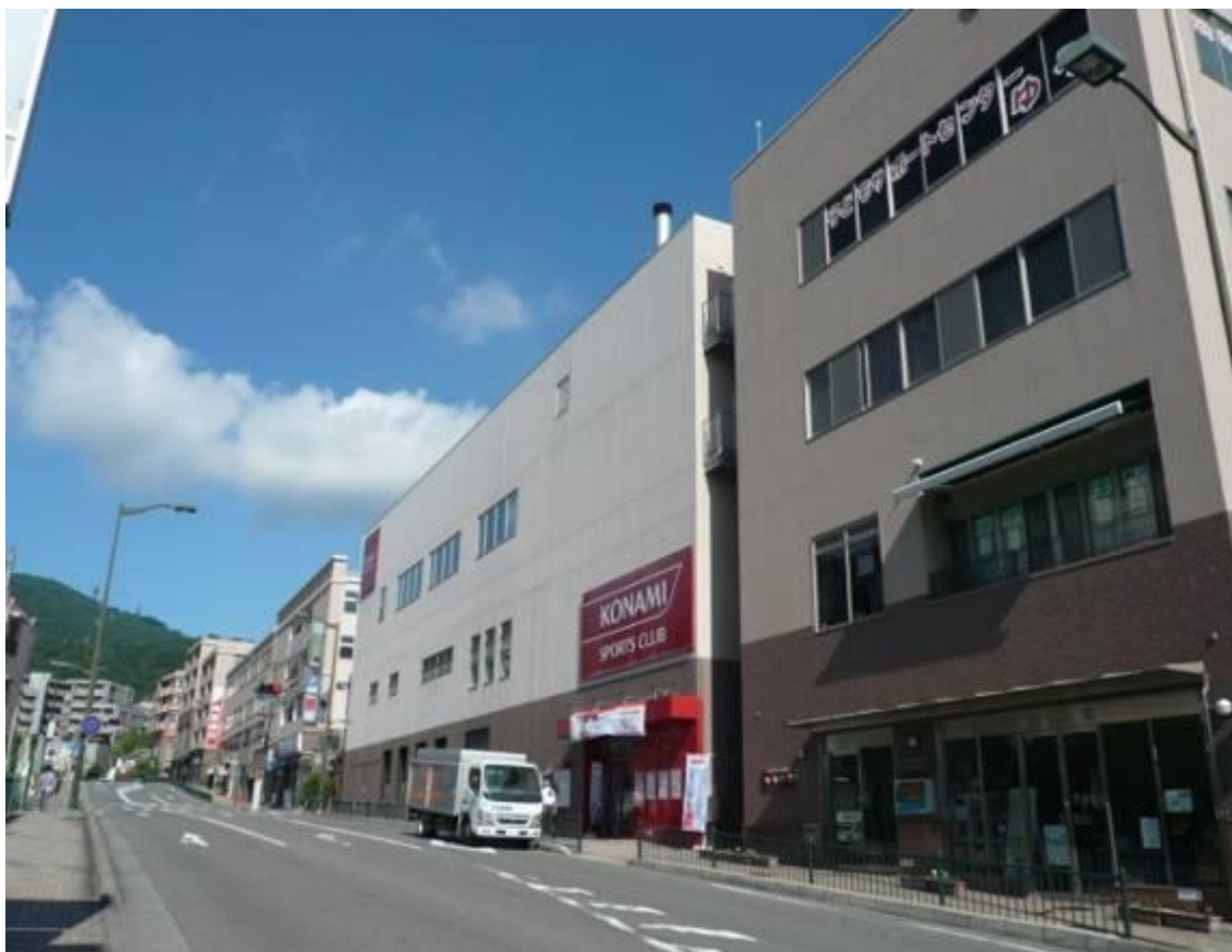
生駒駅北口：第4地区商業エリア
