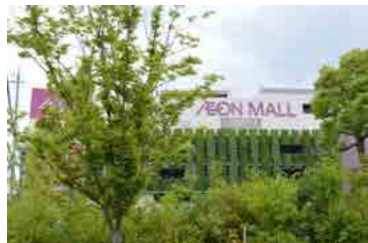
敷地内に緑を積極的に増やした例（伊丹市）
