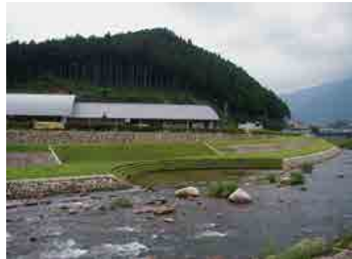
法面を分節化し、緑化を施した例（栄栗市）
