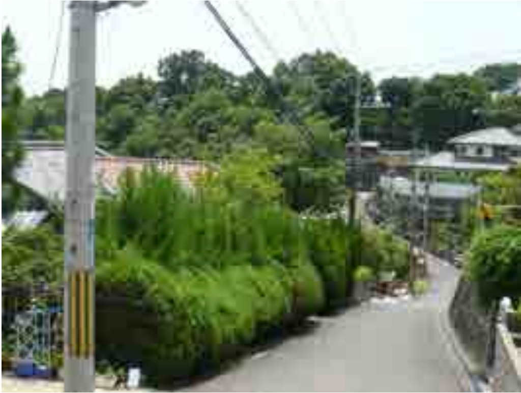
小さな石積み等を用いながら斜面に沿って建てられた住宅
