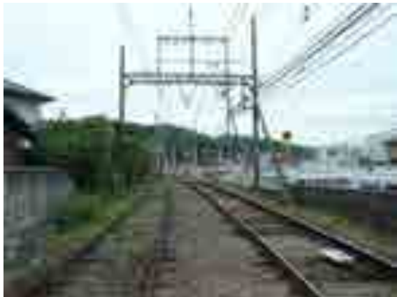
線路上の見通し
