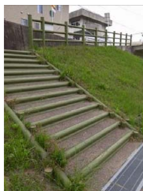
堤防が芝で覆われ、河川 と市街地とを視覚的に つながっている
