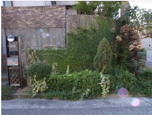
ツタによる擁壁の緑化
