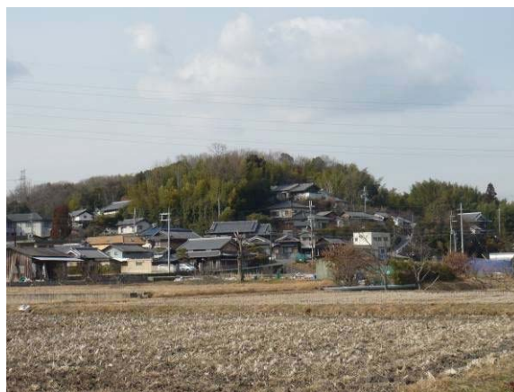
小さな盛り土・切り土により小高い丘の斜面に建設された住宅
