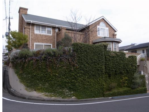
擁壁を緑化する
