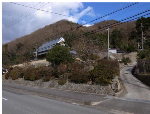
石積みの擁壁
