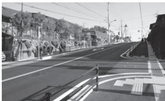
バリアフリー化された歩道（俵口小明線）
