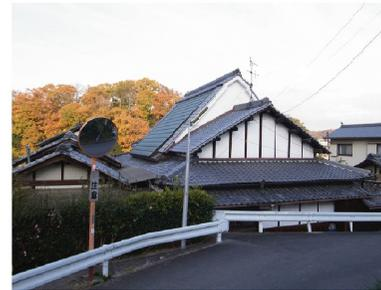
大和棟は、茅葺きの切妻大屋棟（本棟）の左右両側に、数列の平瓦二、三列と、丸瓦で吹き降ろされたタカヘが付いたもの。ここは主屋の床を張った部分にあたり、クド（竈）のある土間部分の屋根は瓦葺の落ち棟であり、檜煙出しが載せられている。生駒市周辺では、台棟生駒型という独自の形態も見られる。
