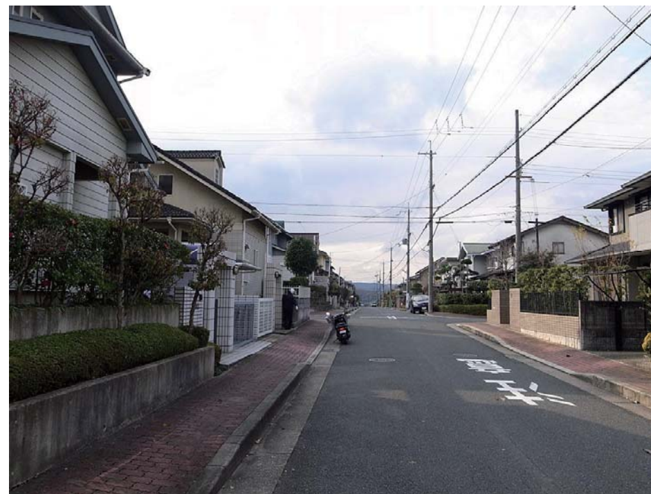
北大和（カラーインターロッキングブロック）
