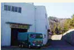
3年度にわたって工事を進めています
