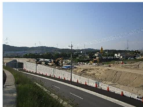
国道163号BP整備 (北田原町地内)
