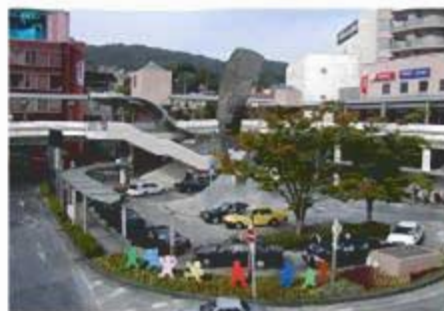
公共空間の緑化 （生駒駅北口駅前広場）
