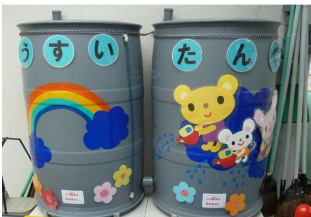
幼稚園・保育園にある雨水タンク
