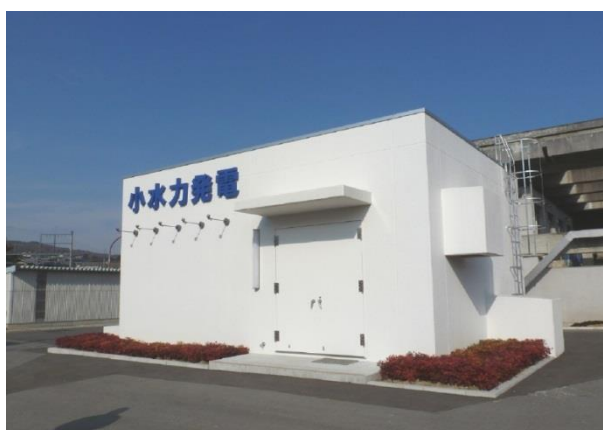
山崎浄水場の小水力発電施設
