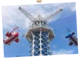
生駒山上遊園地の飛行塔は昭和4年から重く日本最古の遊具
