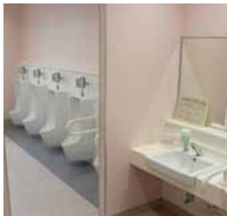
昨年改修した桜ヶ丘小学校のトイレ。乾式の床になり掃除しやすくなりました
