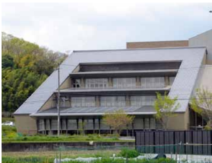
北コミュニティセンターISTAはばたきの屋根に設置した防災型太陽光発電システムと蓄電池。災害で電気の供給が途絶えたときも安心です。
