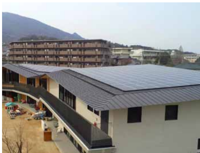
南こども園の屋根を利用して設置した市民共同太陽光発電所2号機(発電容量57.9kWh)。設置費用は市民の皆さんが全額出資しました。
