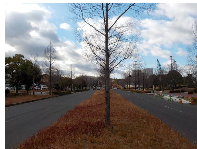
バス停拡幅工事中(H29.1)
