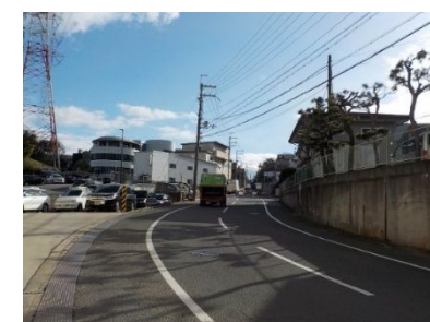
平成28年に整備開通した北田原南北線
