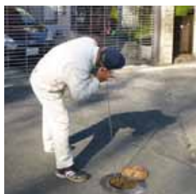
仕切弁での漏水の音聴調査
