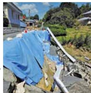
左：川の増水で道路下の土がえぐられ陥落した道路。
