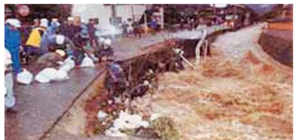
集中豪雨で土石流が発生し、大きな被害が発生した例。地籍調査済みの地区では、土地の境界の測量が終わっていたので、土地の確認作業が円滑に進み、復旧工事が素早く行われた。
