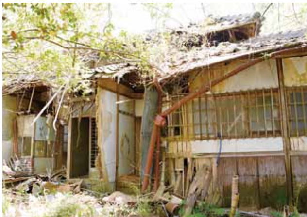
草木が生い茂り、壁や瓦が落ちた危険な老朽空き家。崩れ落ちる危険だけでなく、人が容易に入り込めるため、まちの安全が脅かされる。まちなかでは「夜になると空き家のある一角だけがうす暗く不安」という声も聞かれる。
