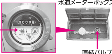
水道メーターボックス
