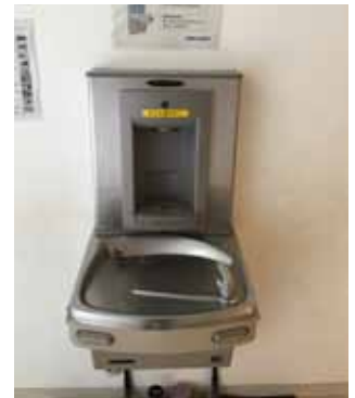
図書館と南コミュニティセンターに新たに設置した「水飲み場」
