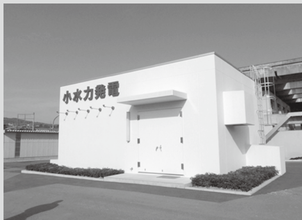
山崎浄水場小水力発電施設
